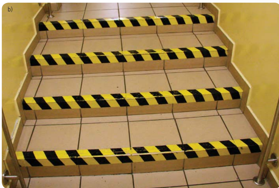
Fot. 2. Przykład oznakowania barwami bezpieczeństwa stopni schodów: a) pasami o barwie żółtej (źródło: CIOP-PIB), b) ukośnymi żółto-czarnymi pasami (źródło: CIOP-PIB) Photo 2. Sample colour safety marking on stairs: a) yellow stripes, b) diagonal yellow-black stripes
