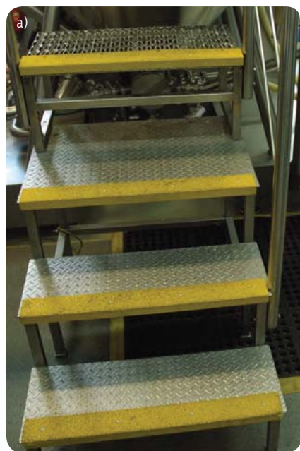
Fot. 2. Przykład oznakowania barwami bezpieczeństwa stopni schodów: a) pasami o barwie żółtej (źródło: CIOP-PIB), b) ukośnymi żółto-czarnymi pasami (źródło: CIOP-PIB) Photo 2. Sample colour safety marking on stairs: a) yellow stripes, b) diagonal yellow-black stripes
