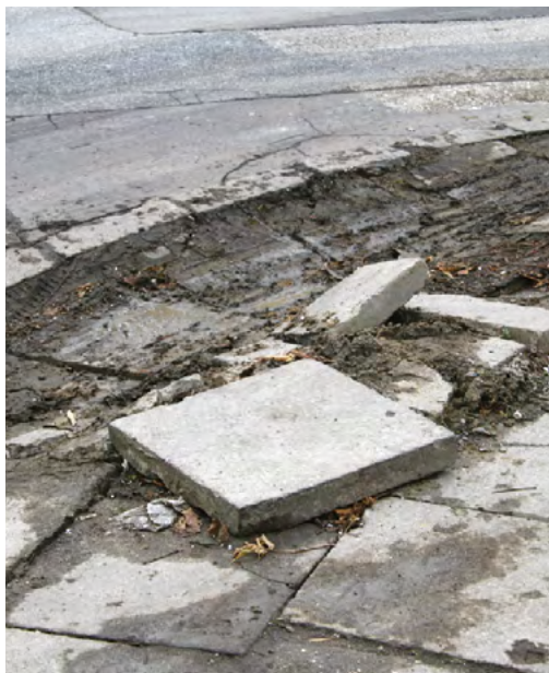
Rys. 2-31. Bariera w postaci zapadniętej nawierzchni chodnika na styku z krawędzią jezdni (źródło: CIOP-PIB)
