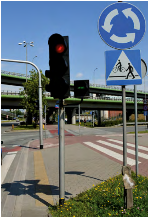
Rys. 2-1. Przykład oznakowania przejścia dla pieszych – znaki poziome, znaki pionowe i sygnalizator świetlny (źródło: CIOP-PIB)
