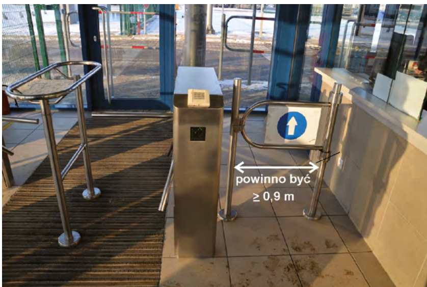
Rys. 2-23. Typowe wejście do zakładu pracy z kołowrotkiem – przykład wejścia wykonanego wadliwie ze względu na zbyt małą szerokość bramki (źródło: CIOP-PIB)
