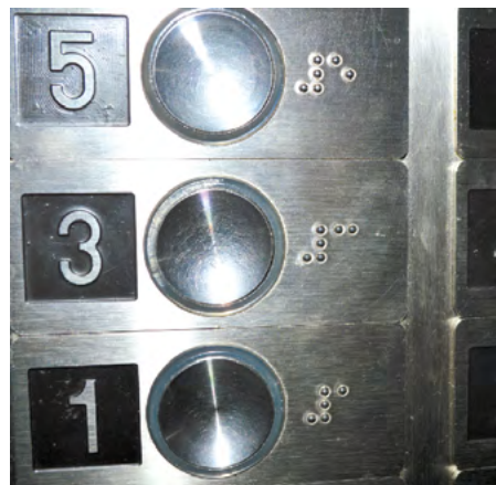
Rys. 2-38. Poprawnie wykonana tablica przyzywowa wraz z wyświetlaczem i modulem głośnomówiącym (źródło: CIOP-PIB)
