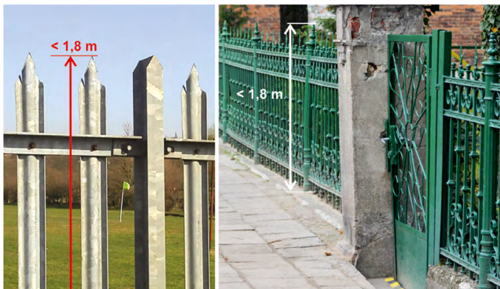
Rys. 2-7. Przykłady wadliwie wykonanych ogrodzeń (źródło: fot. GR8DAN, Wikimedia Commons; fot. Si_sebol, Wikimedia Commons)
