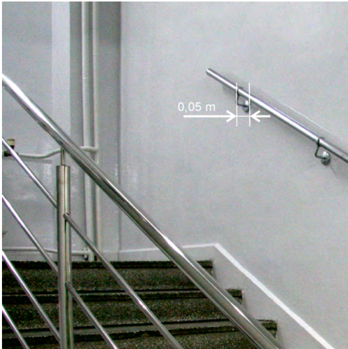
Rys. 2-15. Przykład poprawnego mocowania poręczy przyściennej (źródło: CIOP-PIB)
