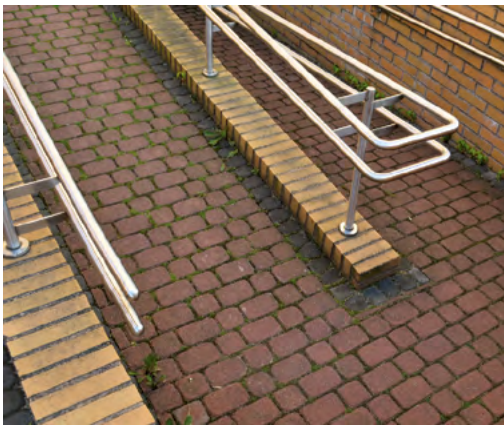
Rys. 2-21. Przykład nawierzchni pochylni zewnętrznej wykonanej z materiału niepowodującego niebezpieczeństwa poślizgu (gładko ułożonego bruku betonowego), (źródło: CIOP-PIB)
