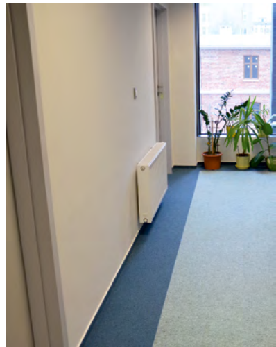
Rys. 2-41. Grzejnik zawężający szerokość przejścia w korytarzu (źródło: CIOP-PIB)
