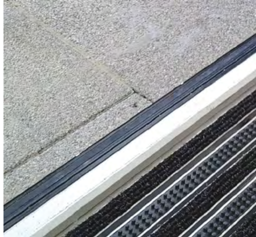
Rys. 2-20. Prawidłowo wykonany próg drzwi wejściowych (źródło: CIOP-PIB)
