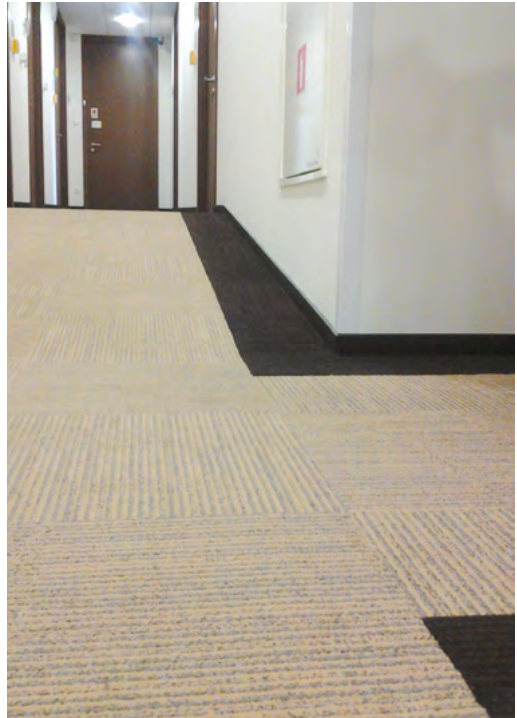
Rys. 2-53. Bordery wykonane w wykładzinie podłogowej (źródło: CIOP-PIB)
