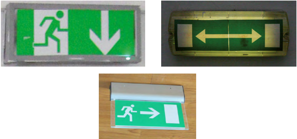
Rys. 3-41. Przykładowe podświetlane znaki ewakuacyjne (źródło: CIOP-PIB)
