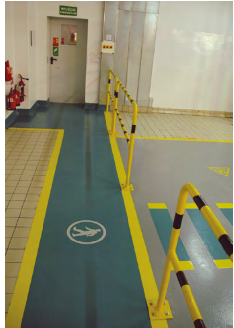
Rys. 2-51. Przykład prawidłowo wykonanej bariery ochronnej zabezpieczającej przed wtargnięciem w strefę obsługiwaną przez wózki jezdne (źródło: CIOP-PIB)
