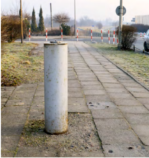
Rys. 2-32. Przykład bariery – wystający z chodnika stałowy element ograniczający przejście (źródło: CIOP-PIB)
