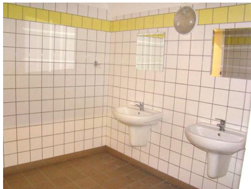
Pomieszczenia higieniczno-sanitarne w Browarze w Elblągu dla podwykonawców
